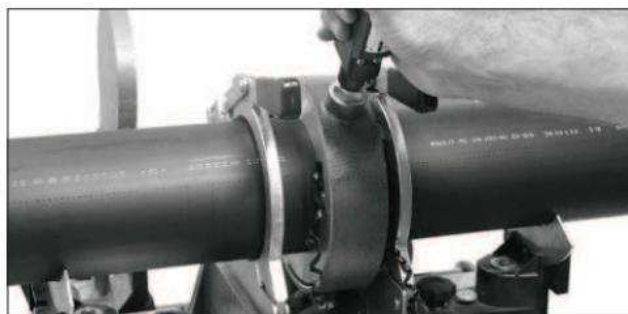
Srovnání konců potrubí integrovaným hoblíkem
